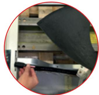
Alimentazione e segnale ventilatore tramite collegamento plug and play per una sostituzione rapida del componente
